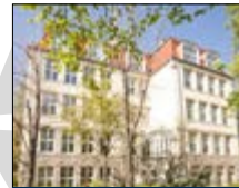
LEHRGEBÄUDE 3 AM HÜGEL 1
